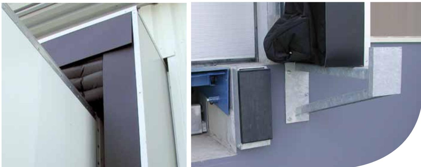
Ventilateur de 3 x 400V (0,37 kW /1300 m<sup>3</sup>/h), les coussins se gonflent en ± 15 s. et se rétractent en ± 25 s. Livré avec un boîtier de commande IP54, protection thermique et lampe témoin.
