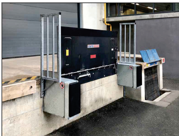
Pont de chargement
